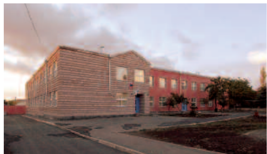
Das Gymnasium mit dem Neubau (links) und dem zum Internat umgebauten bestehenden Schulhastrakt (rechts).
