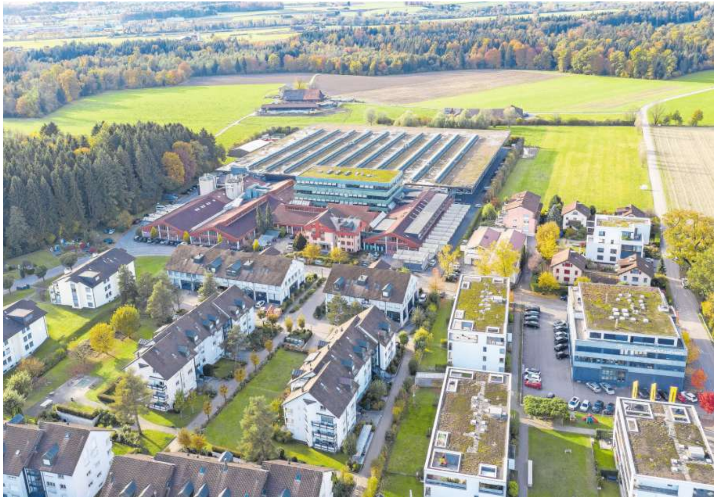
Die Produktionshalle und die Bürogebäude der Fensterfabrik können erweitert werden.
