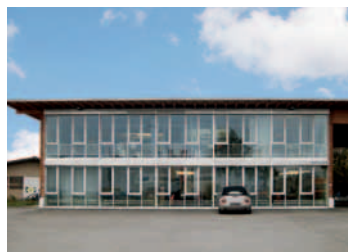
Neubau Werkhof, Bernstrasse/ Überlandstrasse, Schlieren
