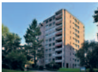
Röhrliberg 28+30, Cham, Sanierung 70 Wohnungen
