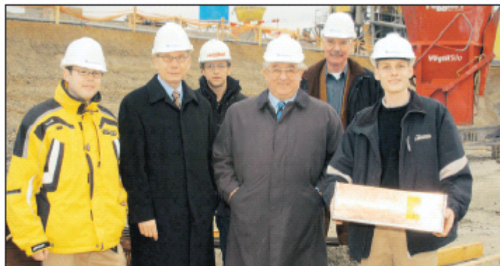
Spatenstich bei Baumgartner Fenster (von links): Adrian Baumgartner; Thomas Baumgartner, Firmeninhaber; Niklaus Graber, Architekt; Alfred Müller, Verwaltungspräsident der Alfred Müller AG; Fritz Heutschi, Projektleiter Alfred Müller AG; Fabian Baumgartner. FOTO PD
