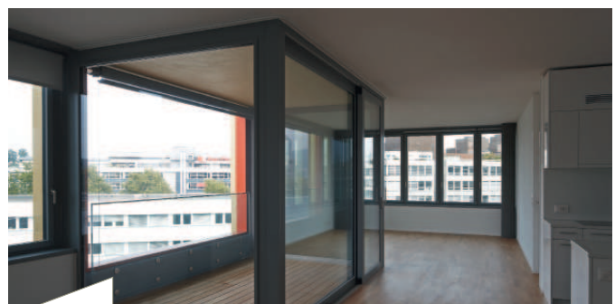
Die Loggien sind durch großformatige Hebe-Schiebe-Elemente aus Holz mit dem Wohnraum verbunden.
